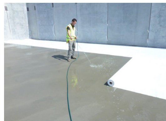
Película plástica para el curado del concreto
