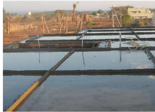
Método de curado por encharcamiento del concreto
