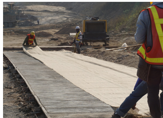
Material de arpillera para el curado del concreto
