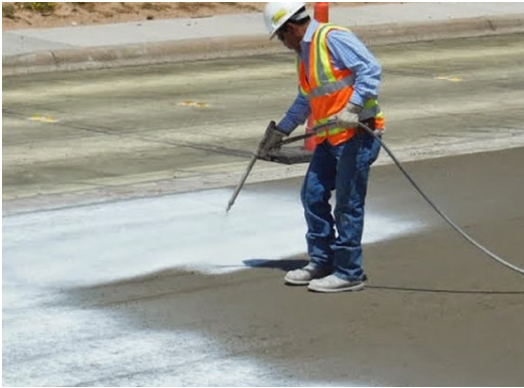
Aplicación de compuestos de curado
