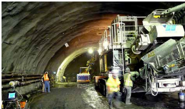
Caldecott 4th Bore: el diseño de distribución de carga permitió reducir el espesor final del revestimiento en un 30%
