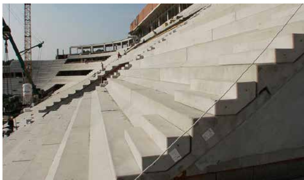
Graderías del Estadio de Debrecen: Se redujo el espesor de los elementos prefabricados de 22 cm a 12 cm.
