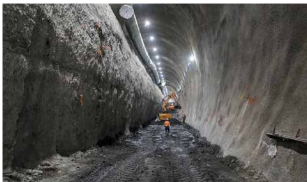
Melbourne Metro: Se eliminó la necesidad de una capa de alisado de 50 mm, lo que redujo el consumo total de hormigón proyectado en un 15 %.
