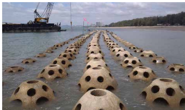
Barreras de control de erosión tipo domo: permitieron la remoción de la cubierta de concreto, reduciendo el espesor de 150 mm a 50 mm.
